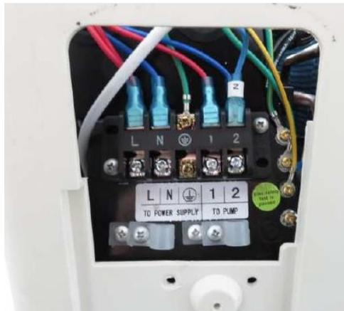
Terminales L y N: Entrada de energía eléctrica 220 V ~ 60 Hz.
